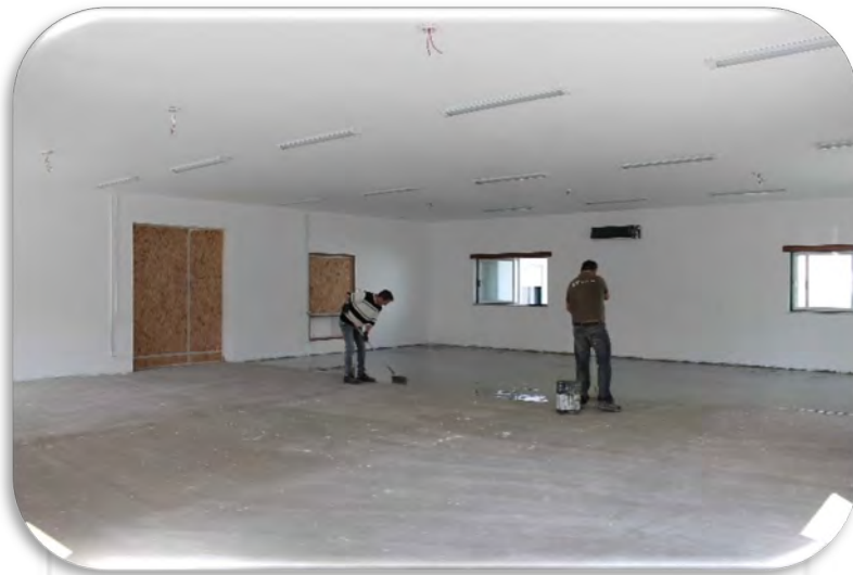
Imagem n.º 15: Intervenção na UMFR
