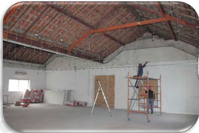
Imagem n.º 14: Intervenção na UMFR
