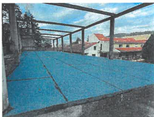
Foto n.º 8: Colocação cobertura Manutenção
