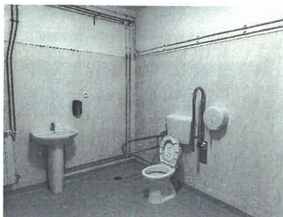
Foto n.º 5: Requalificação I.S. (depois)
