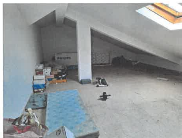
VISTA DOS ARRUMOS DO SÓTÃO
