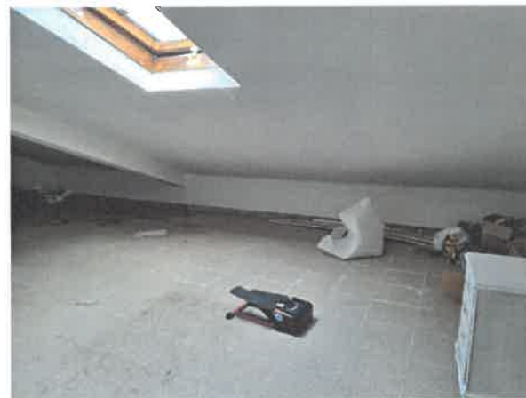
VISTA DOS ARRUMOS DO SÓTÃO
