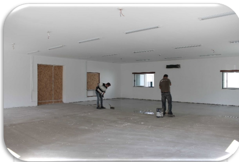
Imagem n.º 15: Intervenção na UMFR
