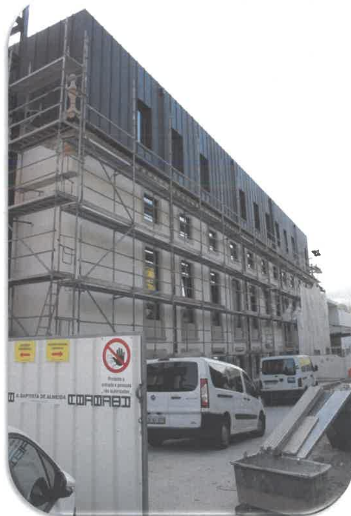
Foto n.º 11: Obras no Hospital de Beneficência Condessa das Canas
