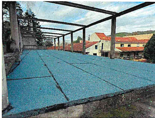
Foto n.º 8: Colocação cobertura Manutenção
