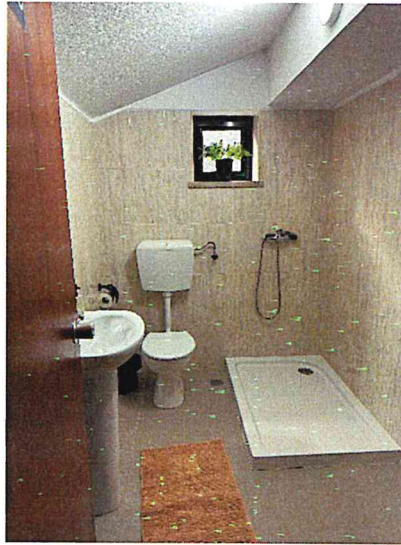
Foto n.º 7: Requalificação I.S. (depois)
