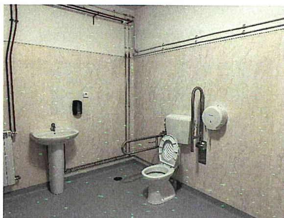
Foto n.º 5: Requalificação I.S. (depois)
