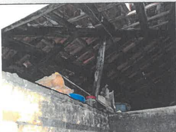
VISTA DO PISO DO SÓTÃO
