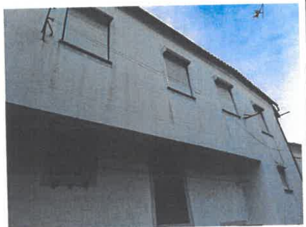
VISTA DO ALÇADO PRINCIPAL
