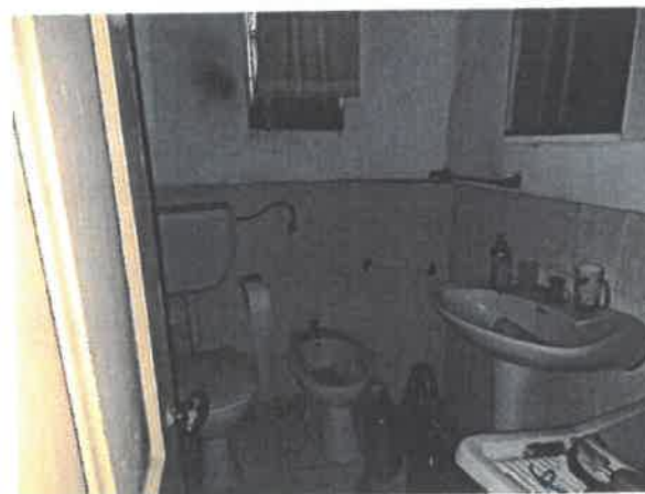
VISTA DE UMA DAS CASAS DE BANHO
