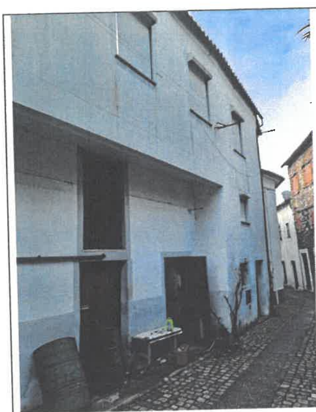
VISTA DO ALÇADO PRINCIPAL
