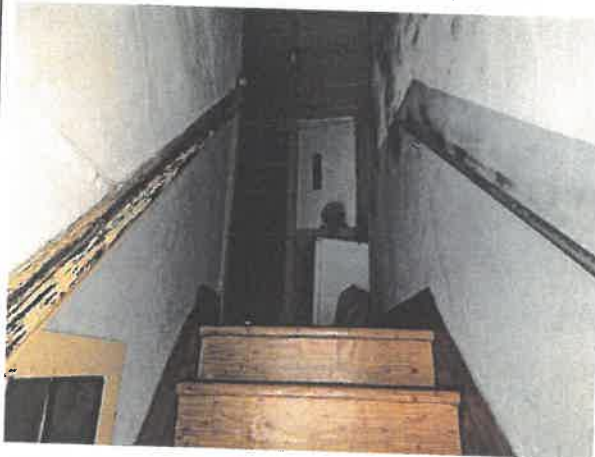
VISTA DA ESCADA DE ACESSO AO 1º ANDAR
