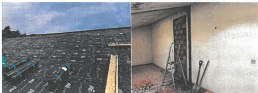
(Fotos n.ºs 31 e 32: colocação de tela isolante e remodelação espaço de arquivo técnico)
