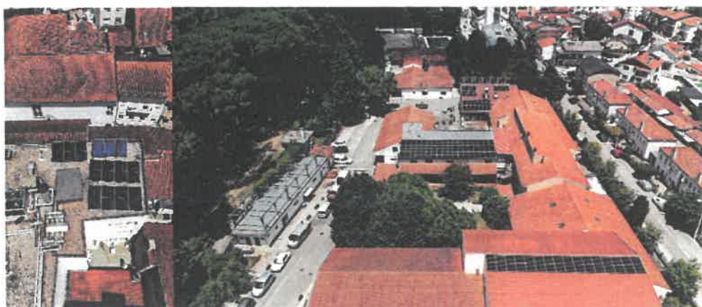
(Fotos n.º 28 e 29: edificado depois da instalação sistema de painéis fotovoltaicos)
