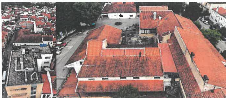
(Fotos n.ºs 26 e 27: edificado antes da instalação dos painéis fotovoltaicos)
