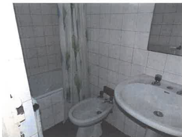
VISTA DA CASA DE BANHO DO SÓTÃO
