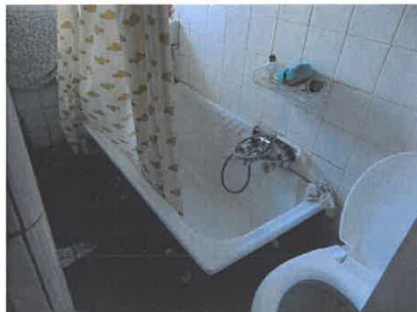
VISTA DA CASA DE BANHO DO 1º ANDAR
