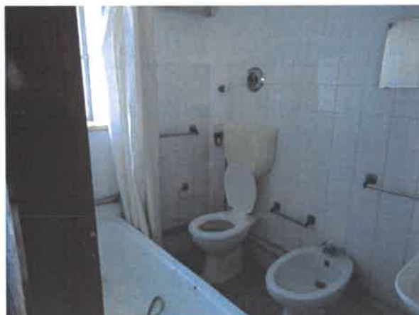
VISTA DA CASA DE BANHO DO R/CHÃO
