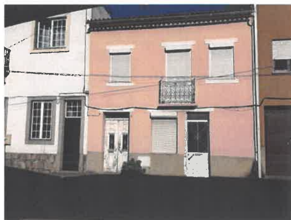
VISTA DO ALÇADO PRINCIPAL
