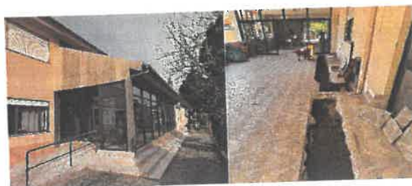
Fotos n.ºs 42 e 43: Melhoria espaços (caixilharia da receção – serviço externo e tubagem esgotos)
