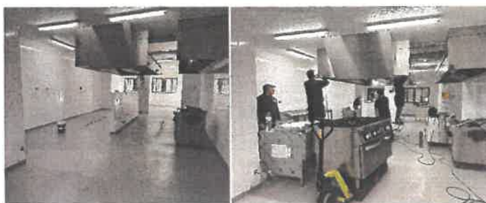
Fotos n.ºs 1 e 2: Intervenção na cozinha e armazém
