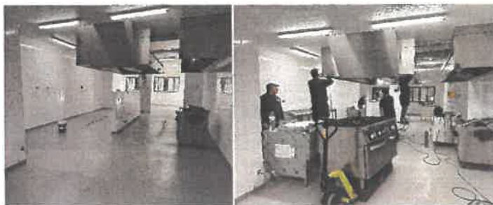
Fotos n.ºs 1 e 2: Intervenção na cozinha e armazém
