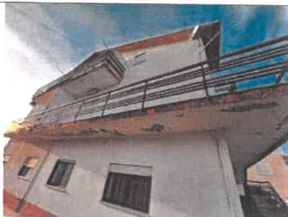
VISTA DO ALÇADO LATERAL ESQUERDO
