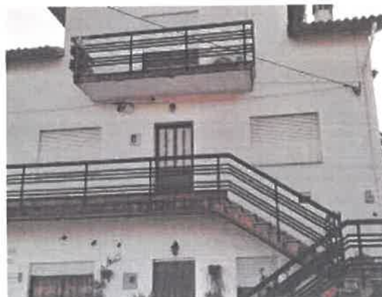
VISTA DO ALÇADO PRINCIPAL DO EDIFÍCIO
